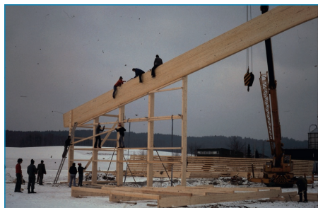
Arbeiten an der neuen Reithalle im kältesten Winter des Jahrhunderts
